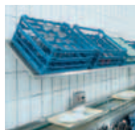
Korbkonsole über einer Korbförderbahn.
